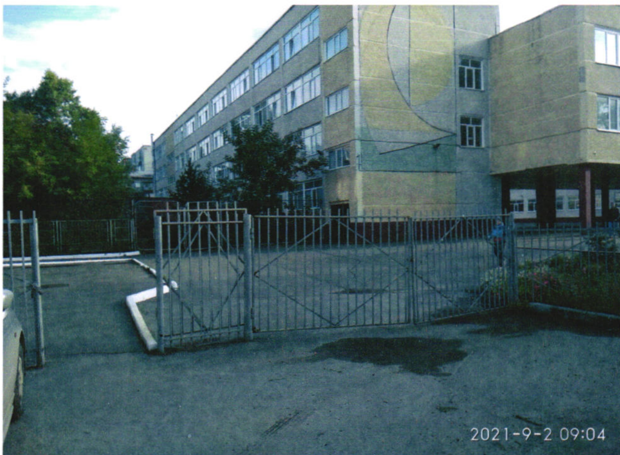
Фото 13. Аварийно-технический въезд (выезд) № 1 на территорию учебного заведения спецтранспорта (со стороны ул. Нахимова, дом № 32).
