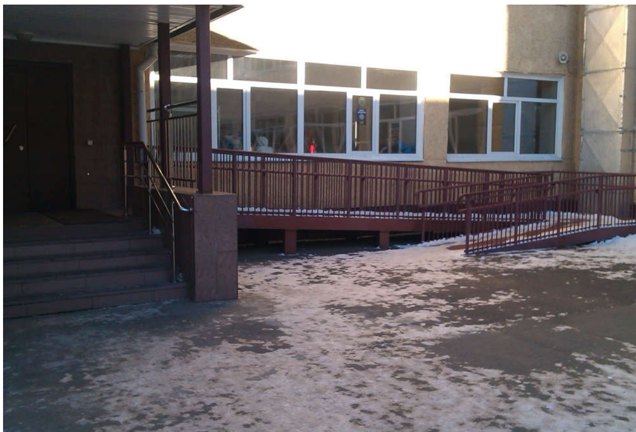
Фото № 7. Состояние доступности основных структурно-функциональных зон. Вход (входы) в здание. Пандус наружный.
