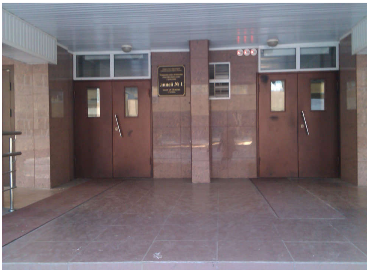
Фото № 10. Состояние доступности основных структурно-функциональных зон. Вход (входы) в здание. Входная площадка (перед дверью).
