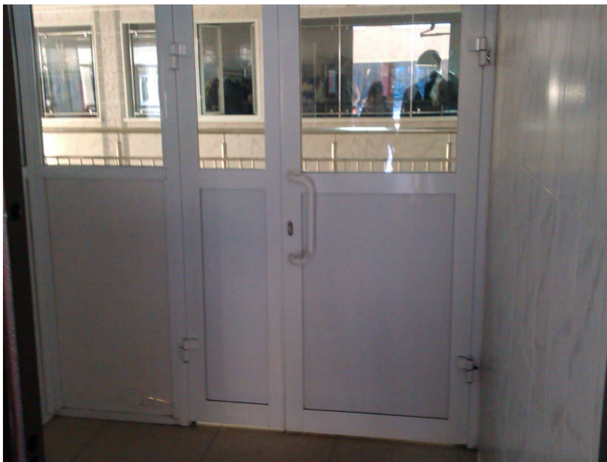
Фото № 12. Состояние доступности основных структурно-функциональных зон. Вход (входы) в здание. Тамбур.
