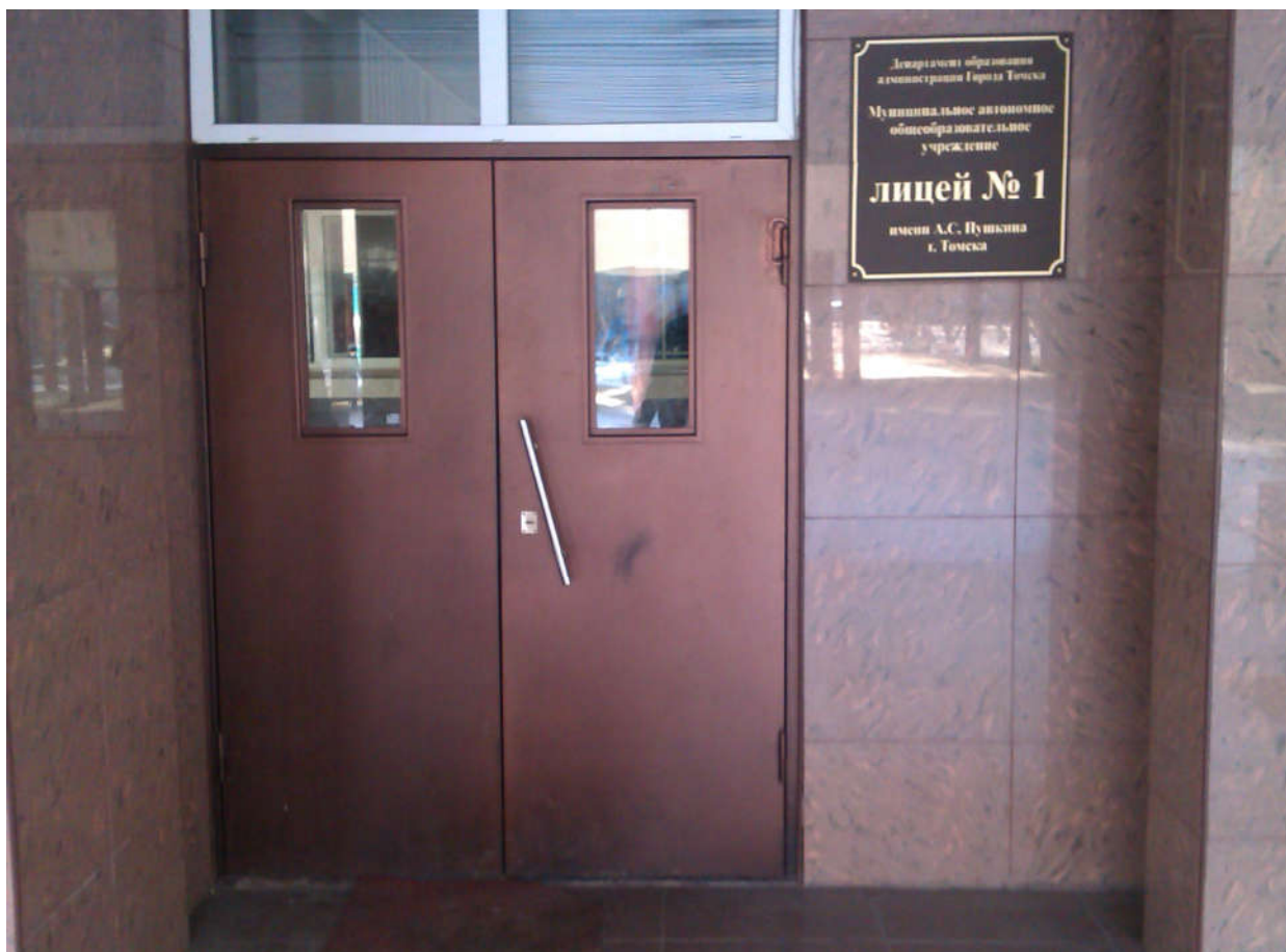
Фото № 11. Состояние доступности основных структурно-функциональных зон. Вход (входы) в здание. Дверь (входная). Система информации на объекте. Визуальные средства.
