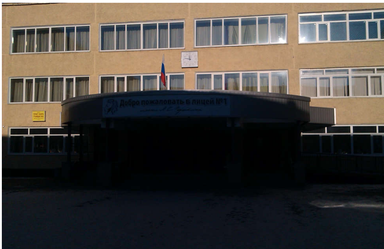
Фото № 6. Состояние доступности основных структурно-функциональных зон. Вход (входы) в здание.
