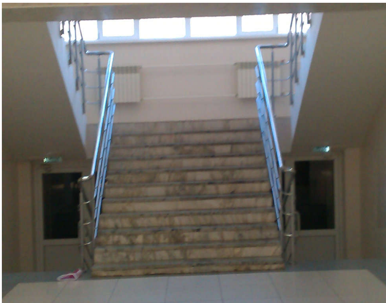
Фото № 14. Состояние доступности основных структурно-функциональных зон. Путь (пути) движения внутри здания. Лестница (внутри здания), правое крыло. Пути эвакуации (в т.ч. зоны безопасности).
